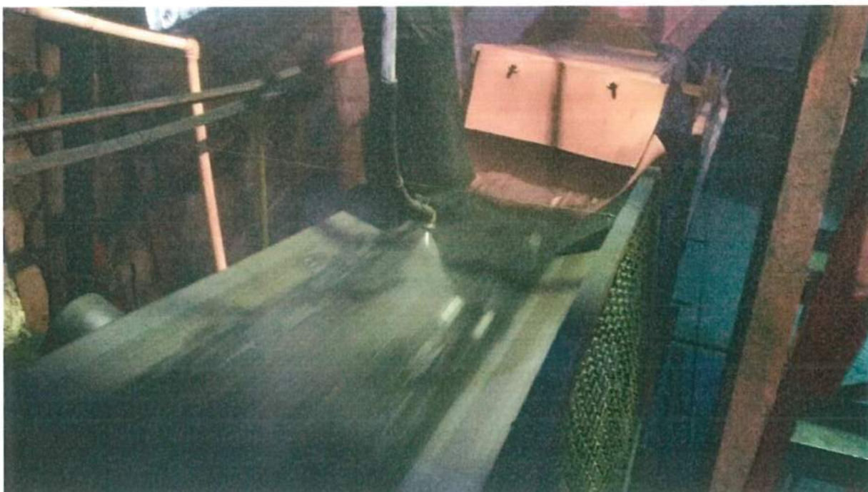
Рис. 2.2. Распылительный узел для орошения дробленого угля в тракте топливоподачи
